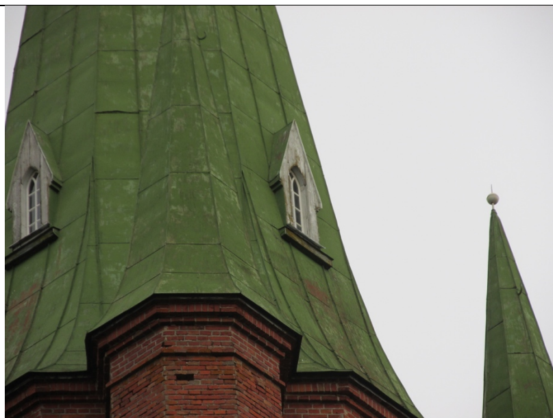
4. attēls. Skats no rietumu puses. Jumta skārds daudzviet ir bojāts
